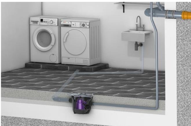
Le poste de relevage *Minilift S* se positionne sans aucun problème sous un évier mais aussi être encastré en dalle. Il permet de raccorder simultanément un lave-linge, une douche ou d'autres arrivées d'eau. Le poste est équipé d'une pompe de 300 W avec interrupteur à flotteur.
