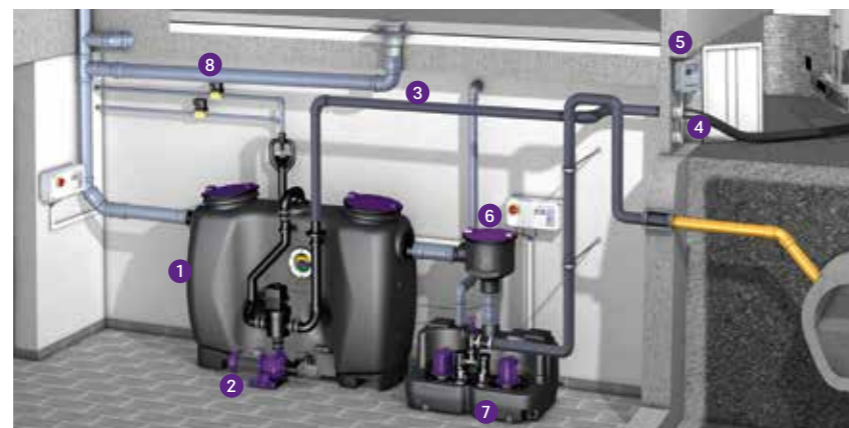
1 Séparateur à graisse 2 Système Schredder-Mix 3 Canne de vidange 4 Raccord d'évacuation pour le camion 5 Télécommande à distance (option) 6 Regard d'échantillonnage 7 Poste de relevage 8 Electrovanne
